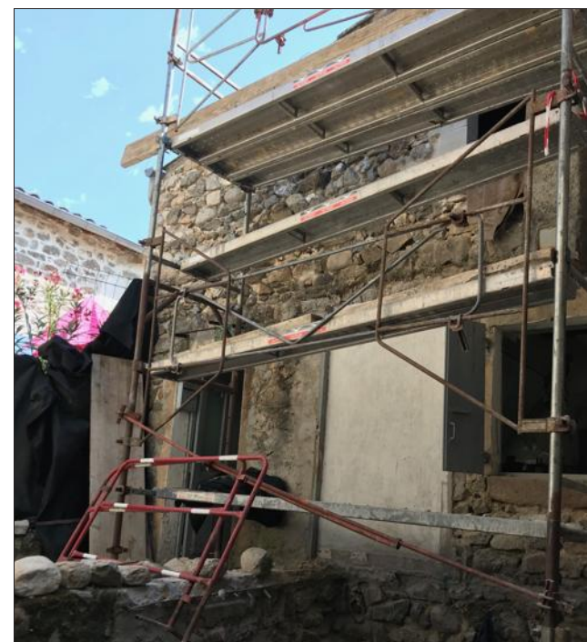
La maison Fargier a subi de lourds travaux.
